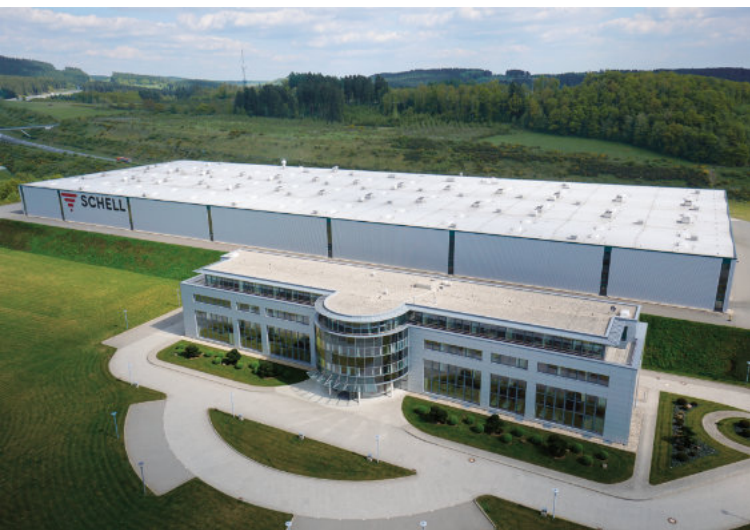
Závod 1 Výrobní hala, administrativní budova a školící centrum
