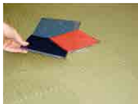
12. Vložit nástavec bez těsnícího kroužku, položit dlažbu
