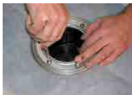
5. Nerezovou svornou přírubu přitáhnout k izolační přírubě vtoku pomocí šroubů z balení
