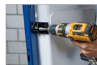
Upevnění nádržky po změně polohy
