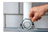
Upevnění splachovacího kolene po zkrácení
