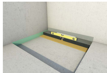
3. Sprchový žlab vlepí ke stěně do stavebního lepidla, popř. nízkoexpanzní PUR pěny a uložit do roviny. Okrajová dilatační páska je součástí tělesa žlabu.
