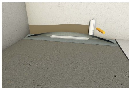
7. Továrně připojenou těsnicí fólii pomocí hydroizolační stěrky zapracovat na hydroizolaci svislé konstrukce
