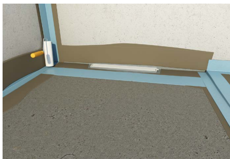
8. Aplikovat těsnicí pásky po obvodu modulu žlabu a prostoru sprchy, utěsnit hydroizolační stěrkou celou plochu sprchy
